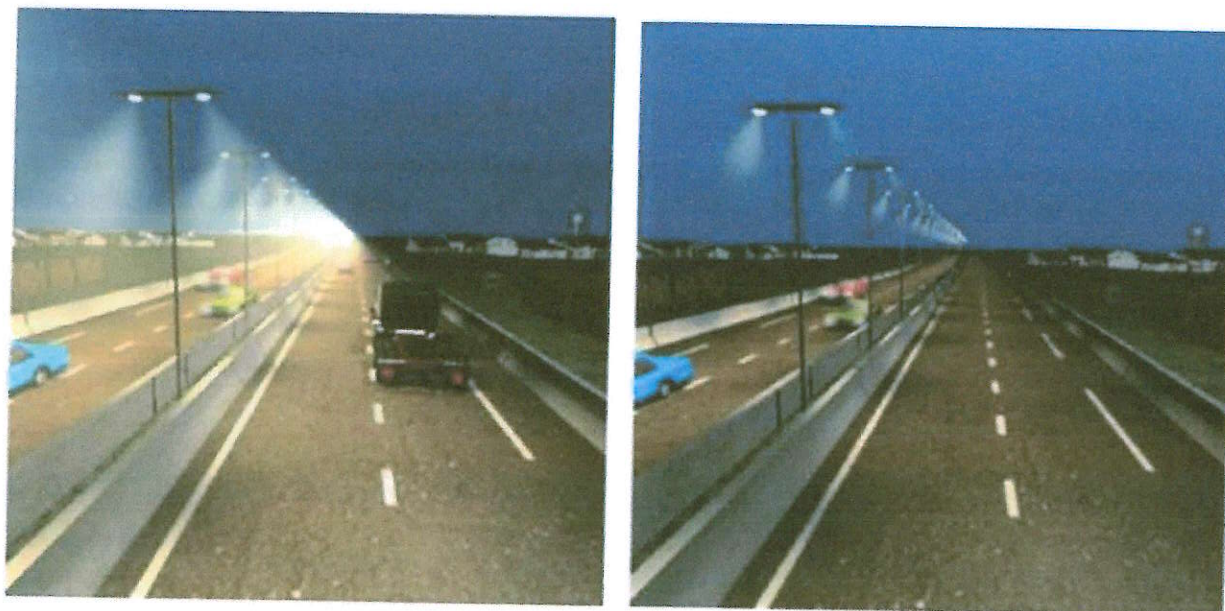
Fig 4. Controlul nivelului de iluminare de la distanță, în funcție de densitatea traficului
